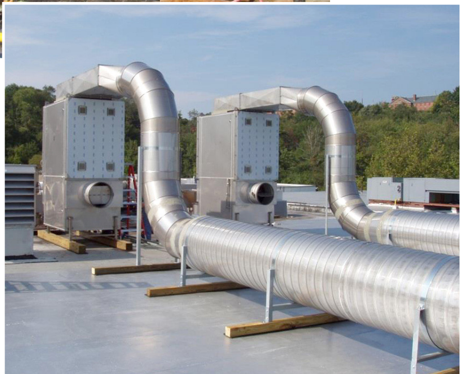
Nach der Installation
