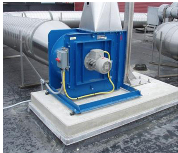
Auf dem Dach platzierter Ventilator.
