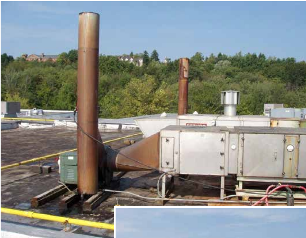
Vor der Installation
