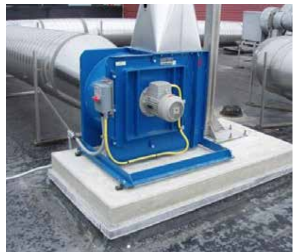
Auf dem Dach platzierter Ventilator.
