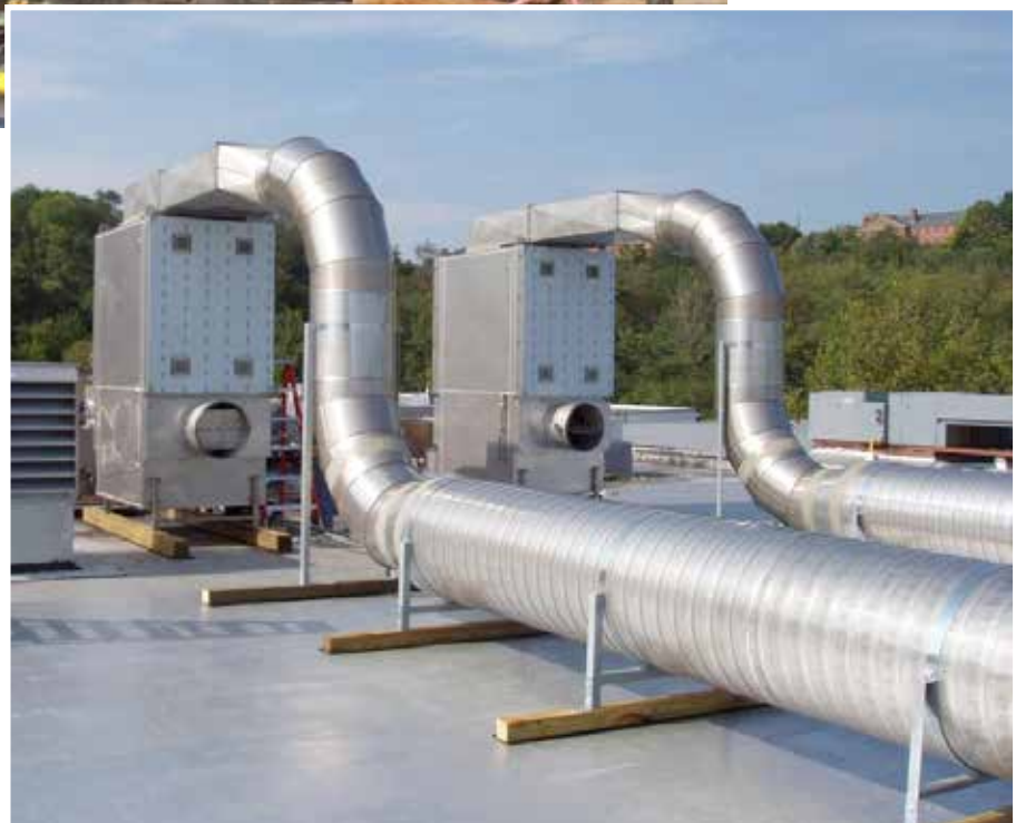
Nach der Installation
