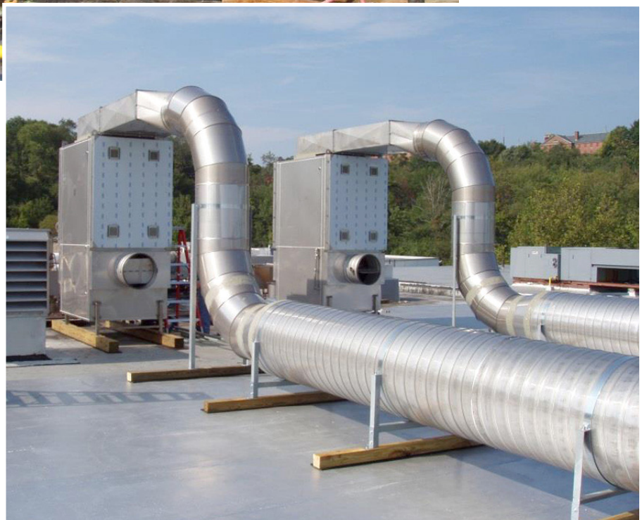
Después de la instalación
