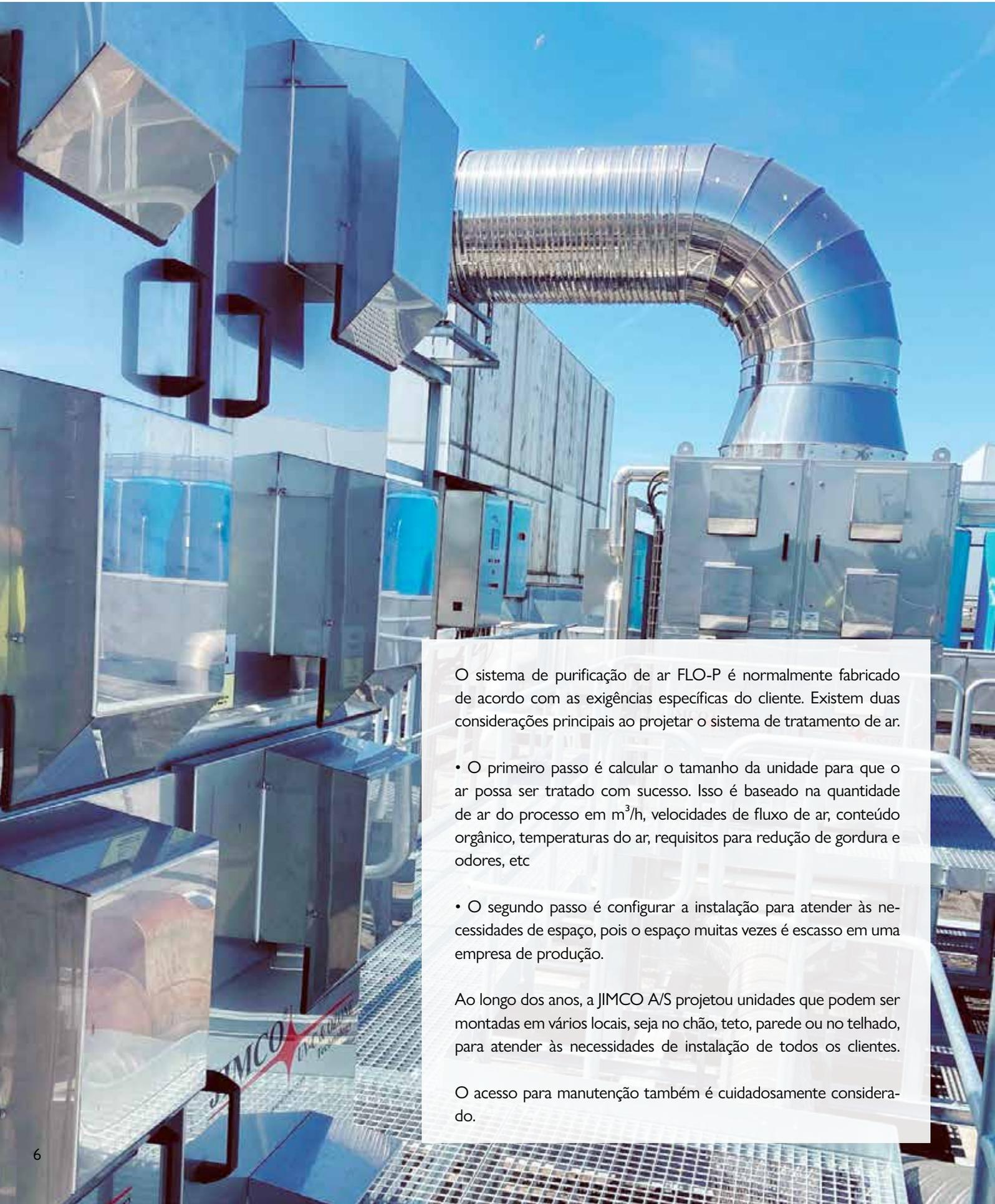
O sistema de purificação de ar FLO-P é normalmente fabricado de acordo com as exigências específicas do cliente. Existem duas considerações principais ao projetar o sistema de tratamento de ar:
