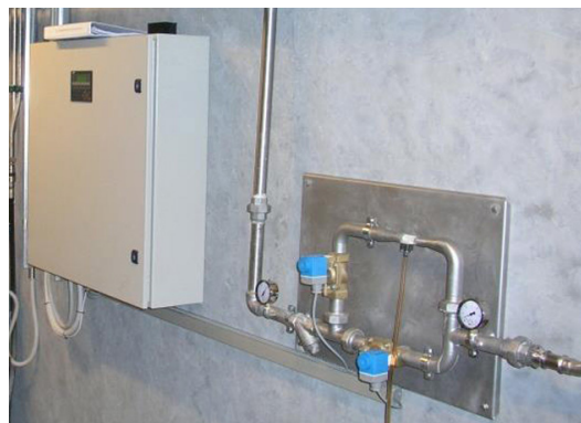
Pannello di controllo Unità di pulizia CIP automatica.
