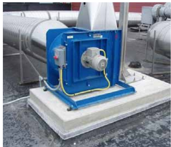
Ventilatore posizionato sul tetto.
