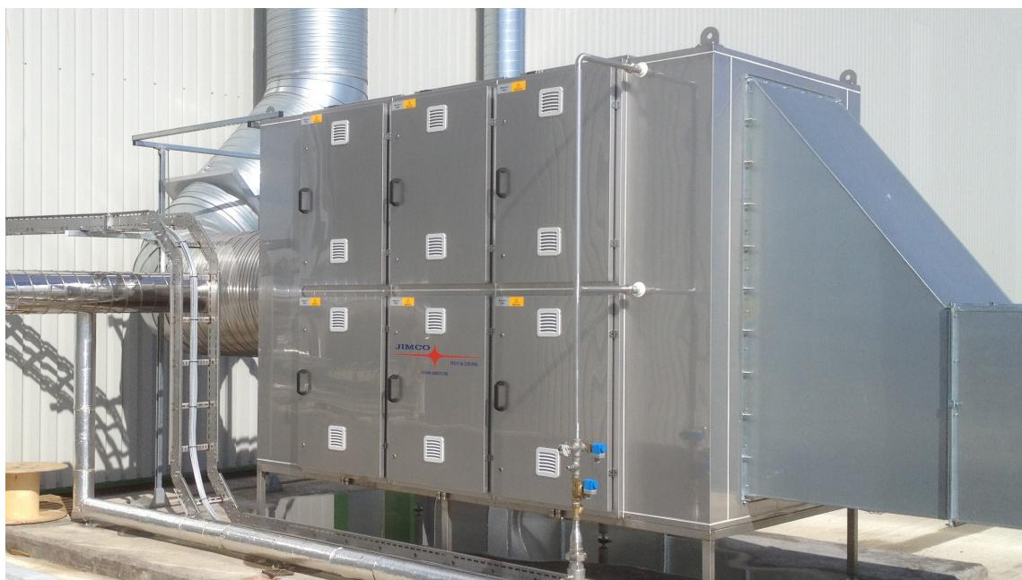
**FLO-K-systemet kan specielt designs til opgaver, hvor der er ammoniak i udblæsningsluften.**
