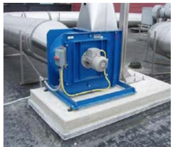
Ventilator placeret på taget
