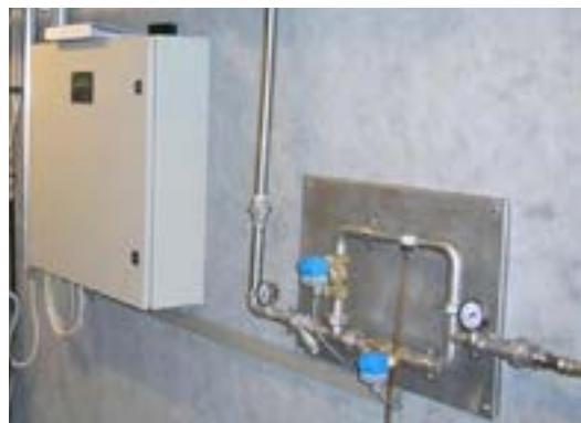
Control panel Automatisk CIP rensningsenhed
